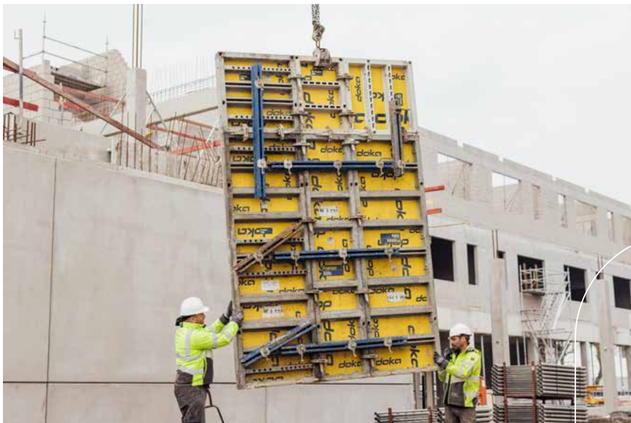
Bekister-betonneerders aan de slag
