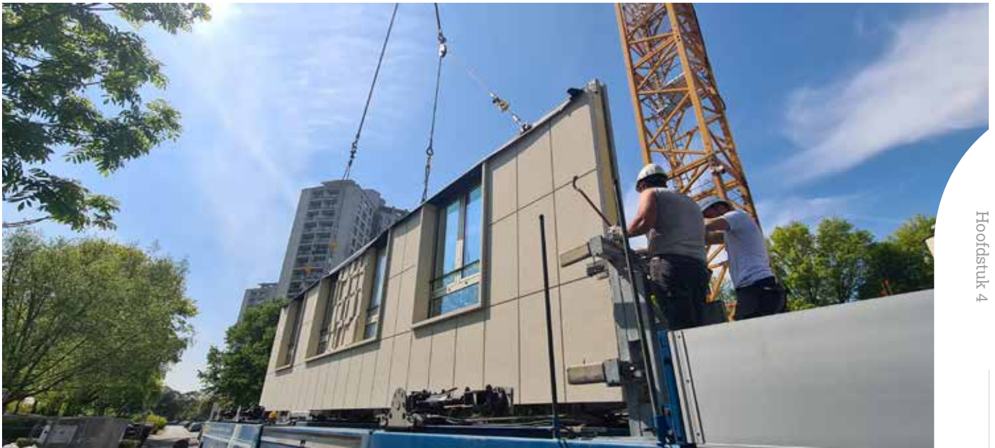
Montage van zware prefabelementen voor de nieuwe Kieparktorens
