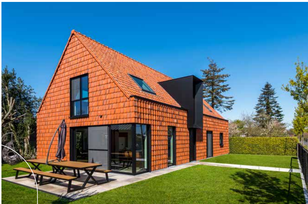
Renovatie van een fermette met na-isolatie en nieuwe uniforme buitenschil
