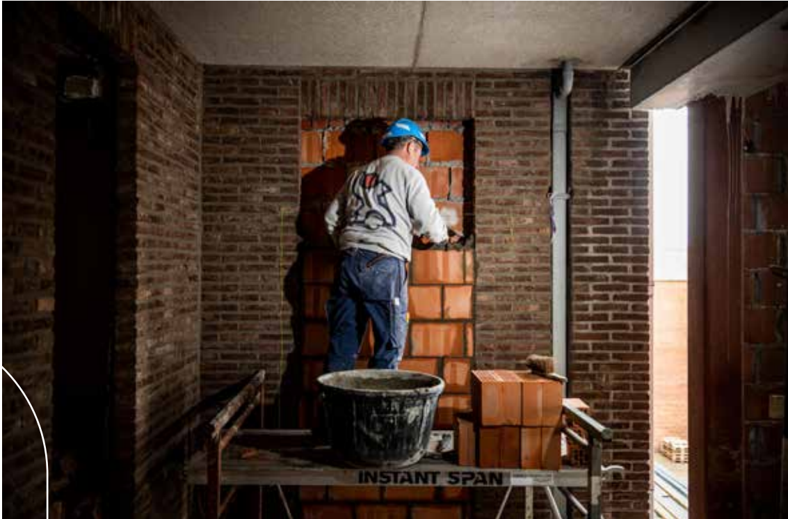
Renovatiewerken voor het WZC Hof Sint-Niklaas
