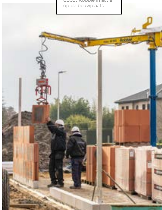
Cobot Robbie in actie op de bouwplaats
