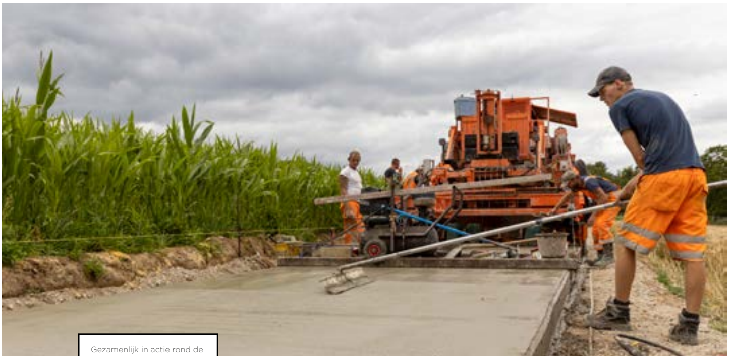
Gezamenlijk in actie rond de betonneringsmachine (ill. Habenu-van de Kreeke)
