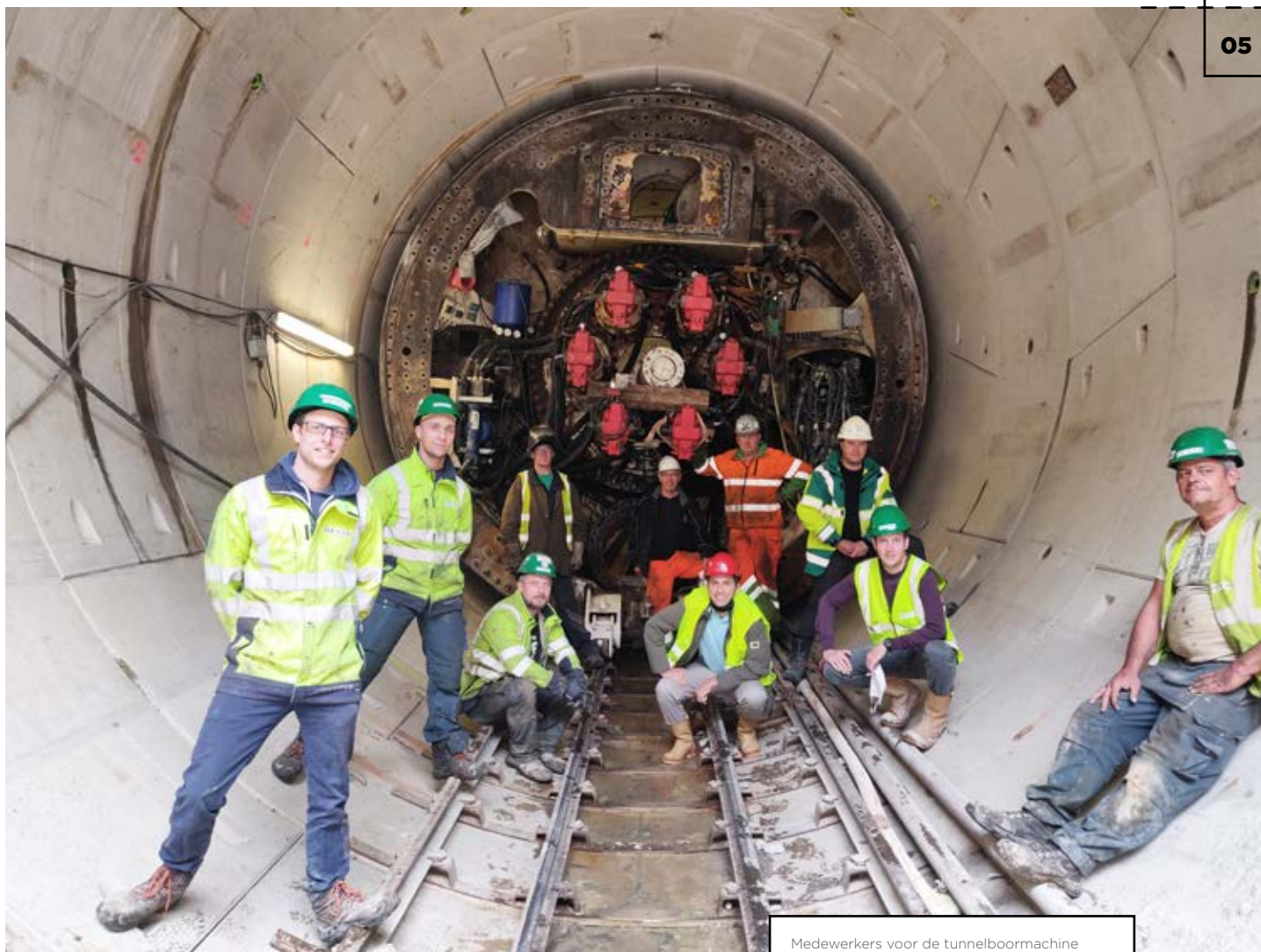
Medewerkers voor de tunnelboormachine gebruikt voor het regenwaterbekken aan de Grootveldlaan te Brussel (ill. Denys)
