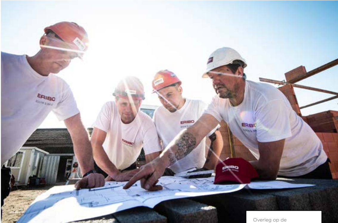
Overleg op de bouwplaats (ill. Eribo)
