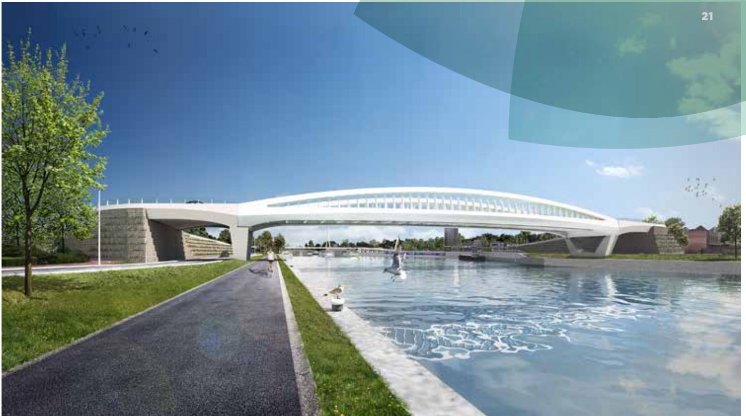
↑ Combinatie van wegbrug met fiets- en voetgangersbrug in Wijnegem (ill. De Waterweg)
