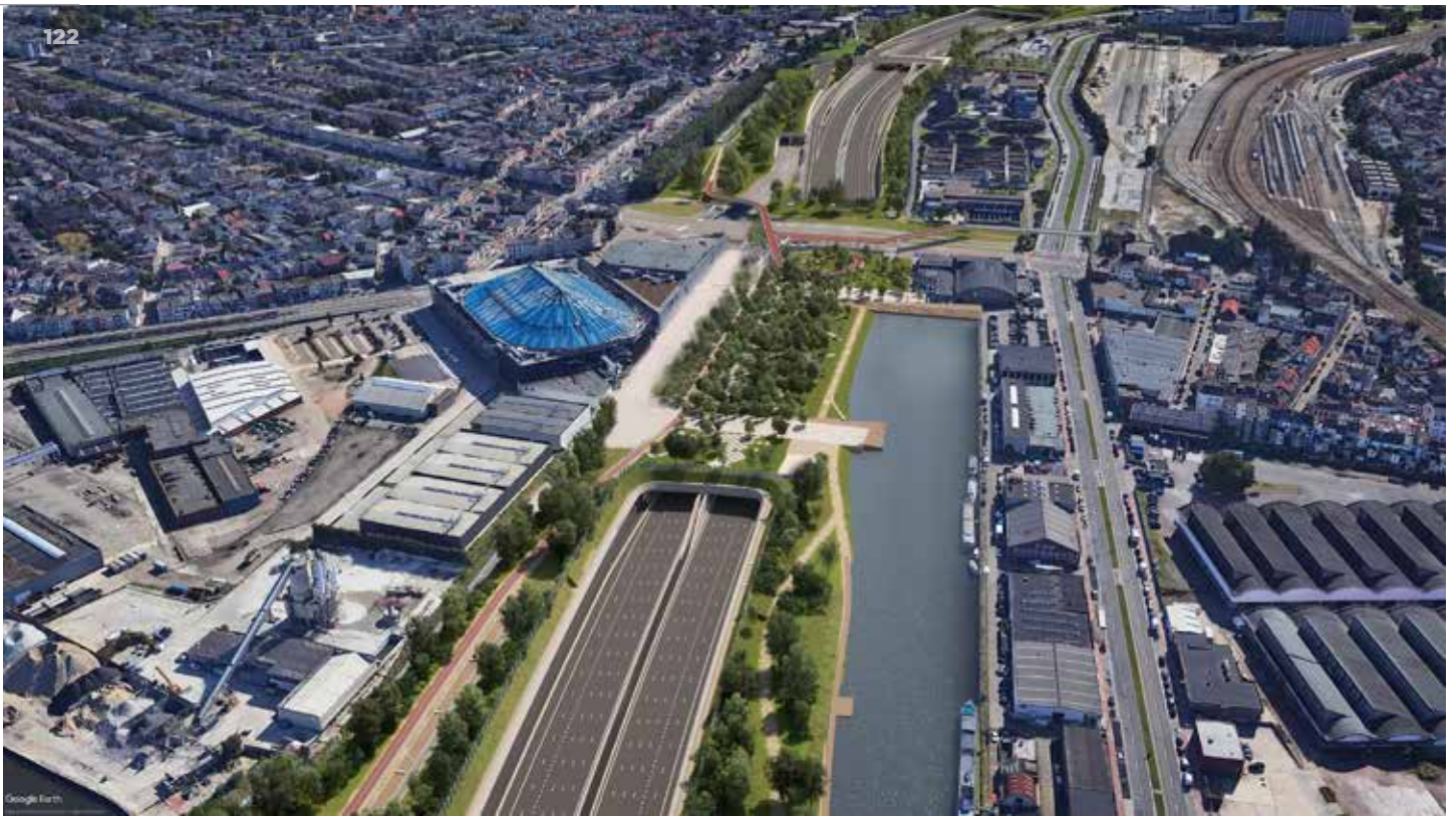
↑ Overkapping van de R1 aan het Sportpaleis (ill. Lantis)
