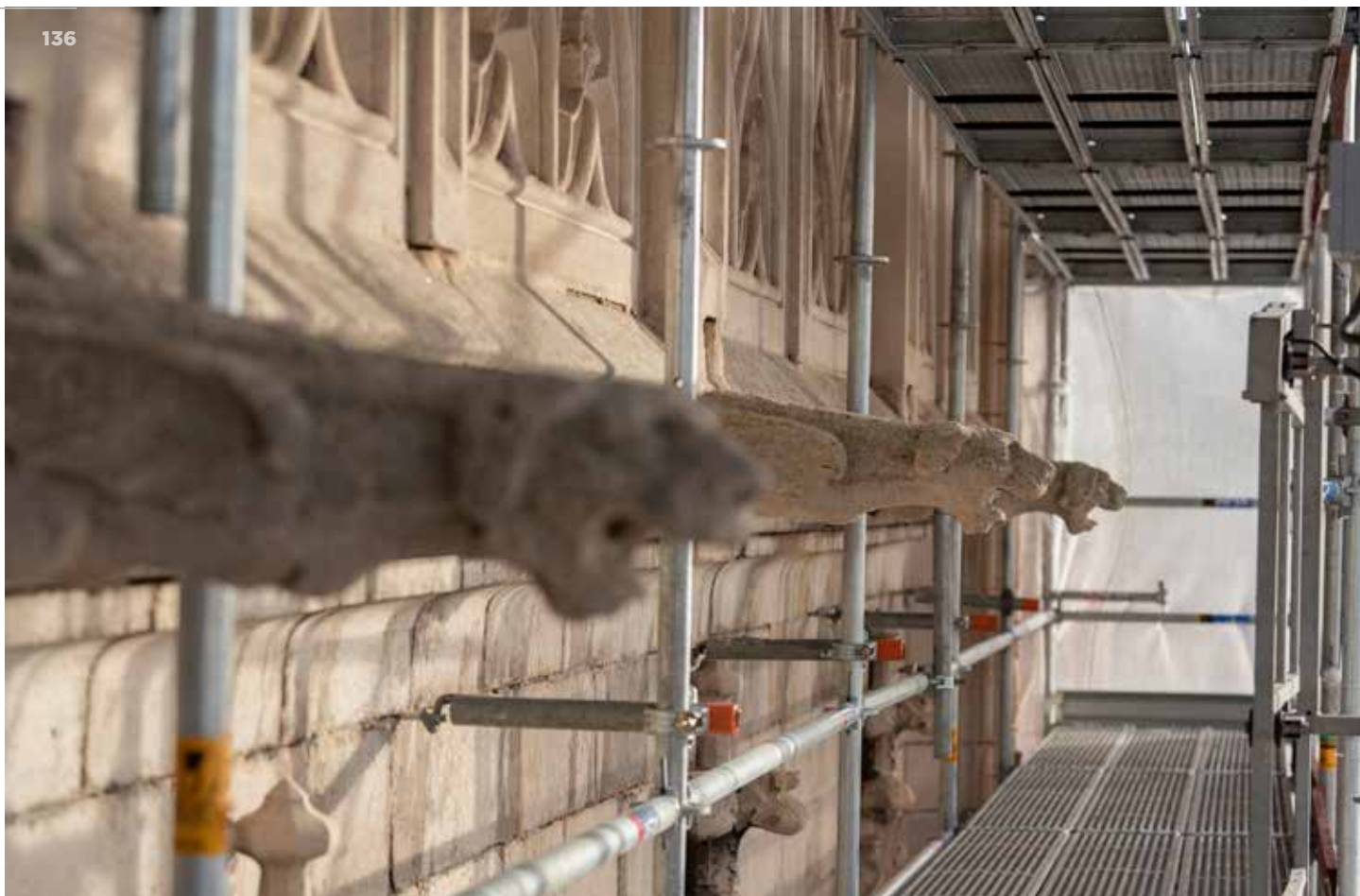
↑ Gevelrestauratie van het Provinciaal Hof in Brugge (ill. Artes)
