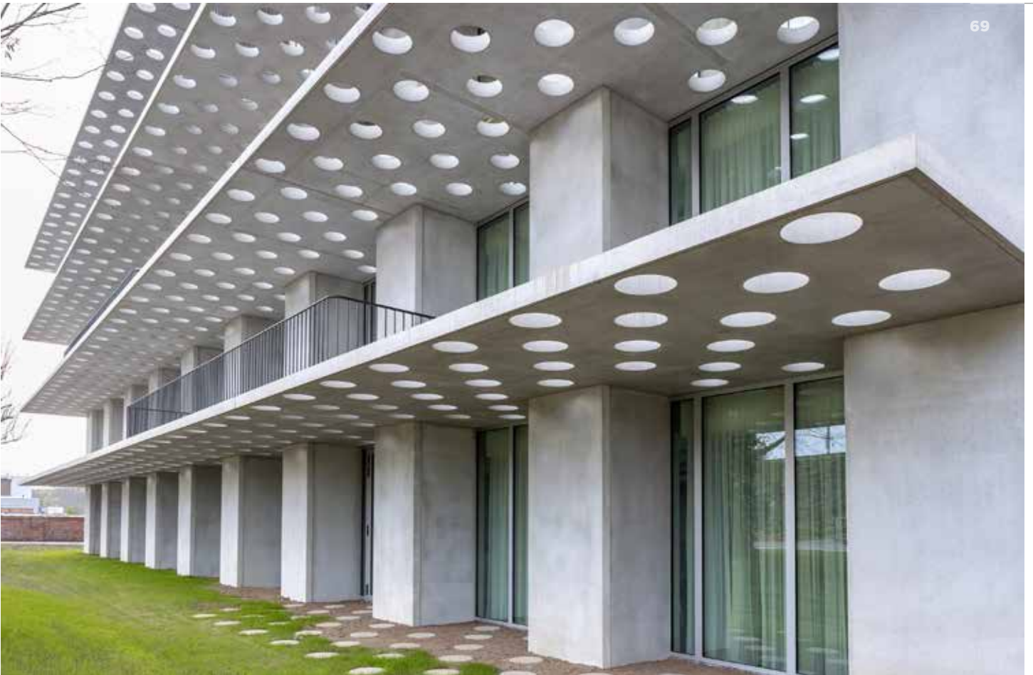
↑ Energiezuinige renovatie van een kantoorgebouw van de jaren '70 te Kortrijk door Himpe (ill. Facilitair Bedrijf, arch. Office KGDVS, foto Kus)
