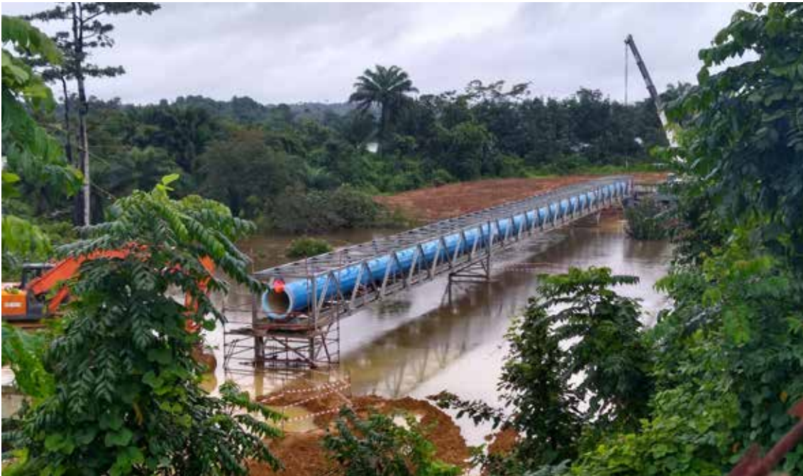
↑ Via Design & Build gerealiseerde ruwwaterleiding in Liberia (ill. Denys)
