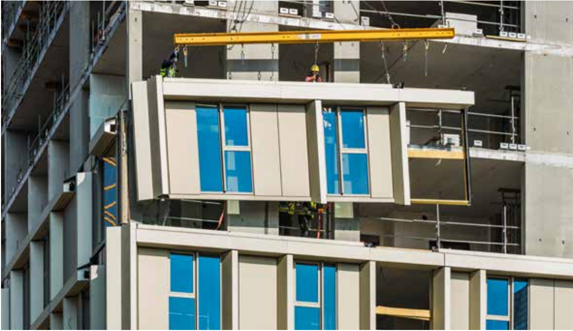
↑ Levering en montage van prefab HSB gevelelementen voor de Doktoren te Antwerpen (ill. Machiels Building Solutions, arch. Binst)
