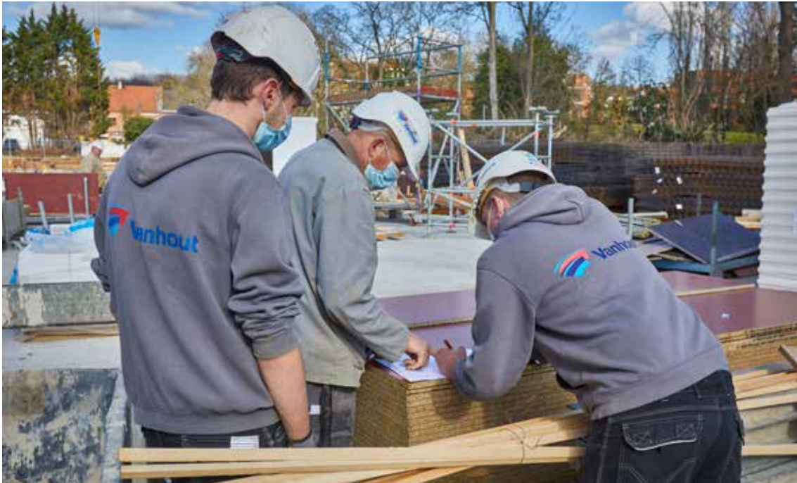
↑ Samenwerking op de bouwplaats in coronatijden (ill. Vanhout)
