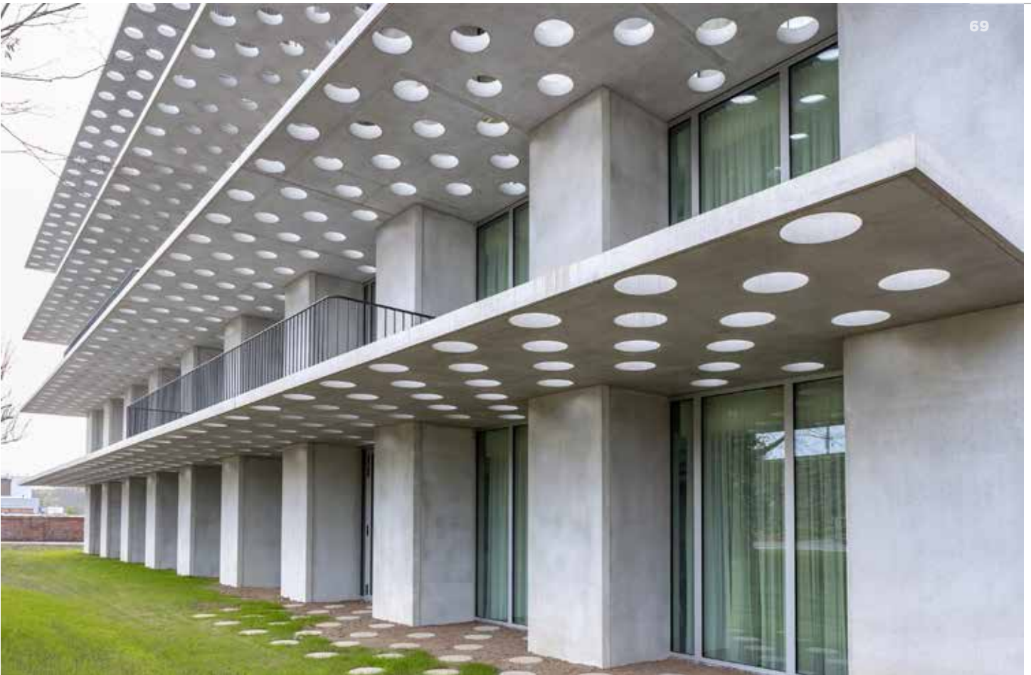
↑ Energiezuinige renovatie van een kantoorgebouw van de jaren '70 te Kortrijk door Himpe (ill. Facilitair Bedrijf, arch. Office KGDVS, foto Kus)
