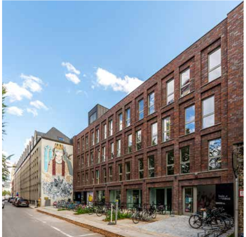
↑ Herbestemming van een politiecommissariaat tot een gebouw voor studenten en vrijzinnigen (ill. Wienerberger)
