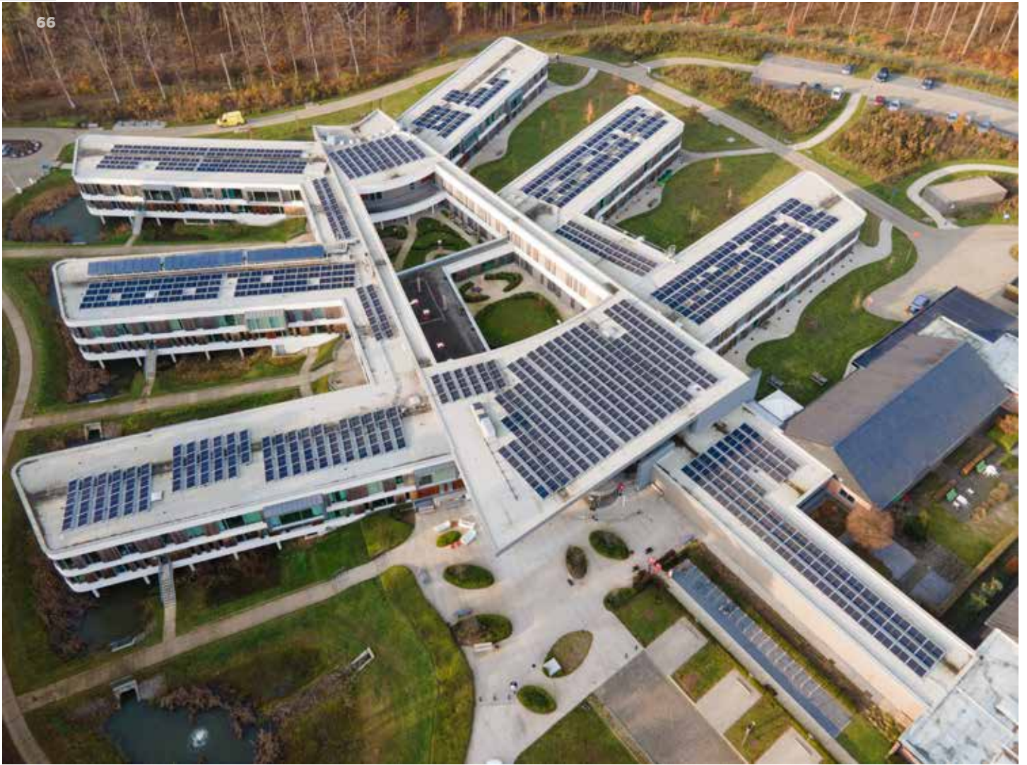
↑ Meer dan 1.000 zonnepanelen op het Sint Anna woonzorgcentrum in Herentals (ill. Vanhout)
